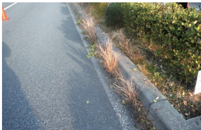
清掃、除染作業前
