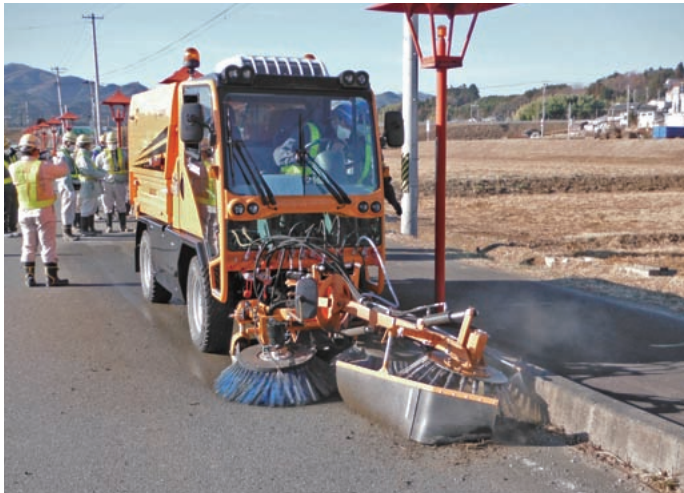
平成 26 年 1 月 福島県楢葉町内 路肩清掃中
