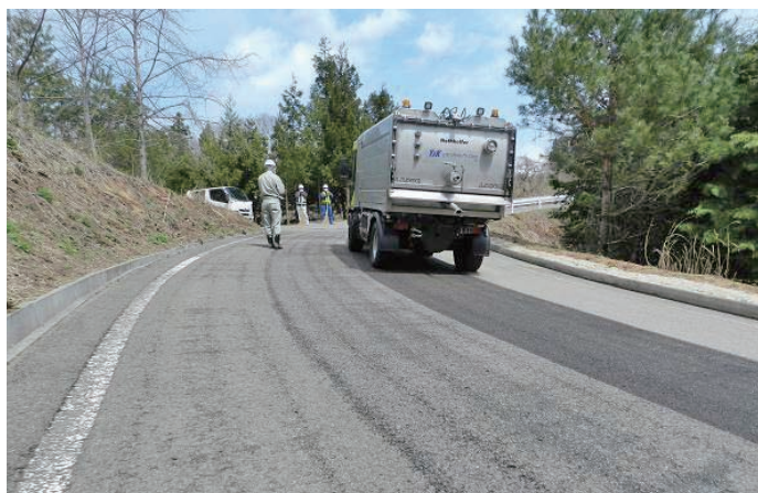
除染作業完了
