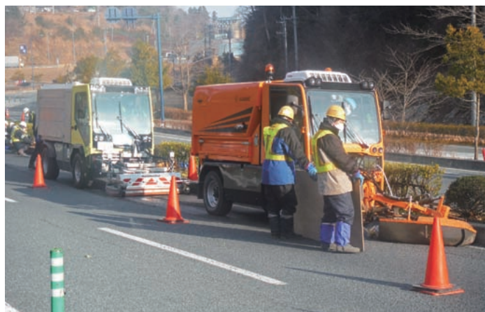
先頭のスイーパーで道路を清掃し、後に続くターボクリーナーで除染する
