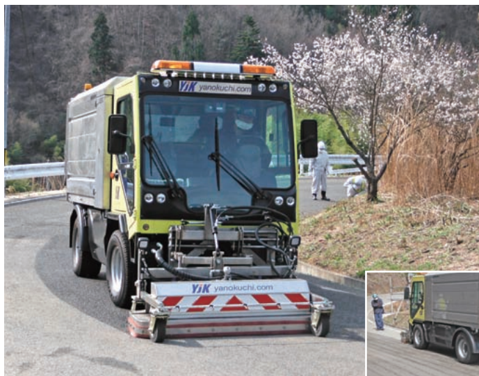
平成25年4月 福島県伊達市内 試験施工中
