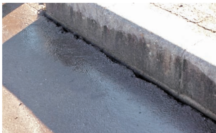
清掃作業終了
